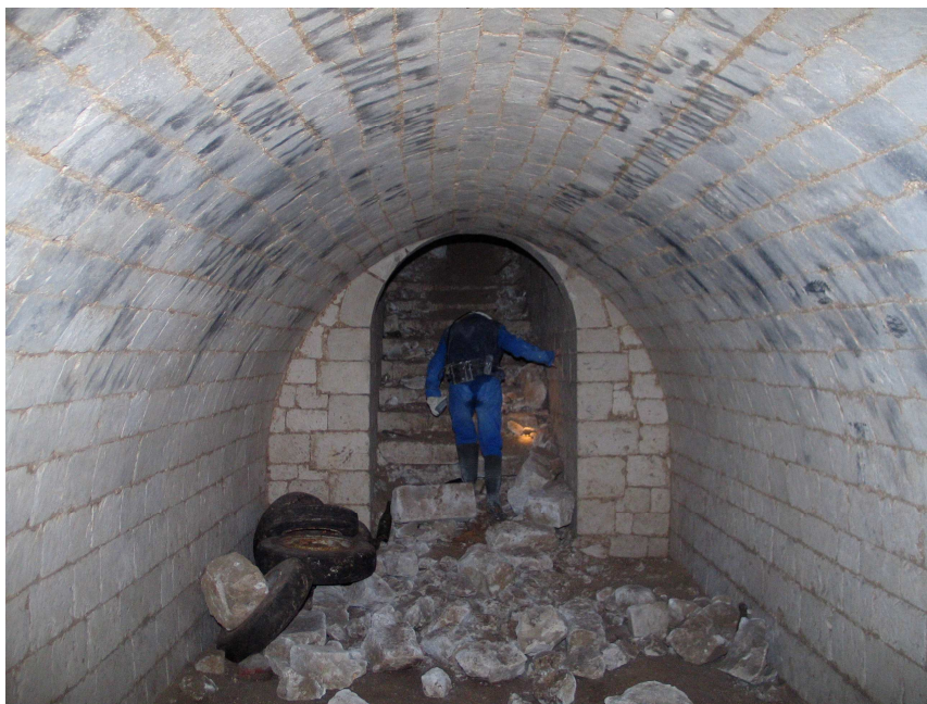
Photo 8 : souterrain de la Commanderie (une des caves)
