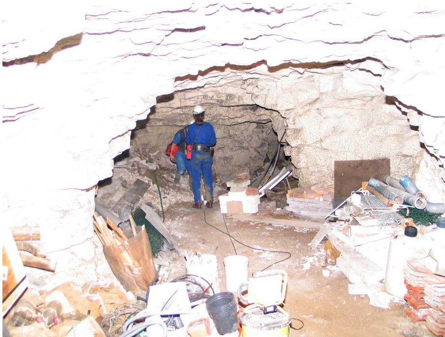
Photo 4 : cavité dont l'accès se fait depuis chez Monsieur Boucher
