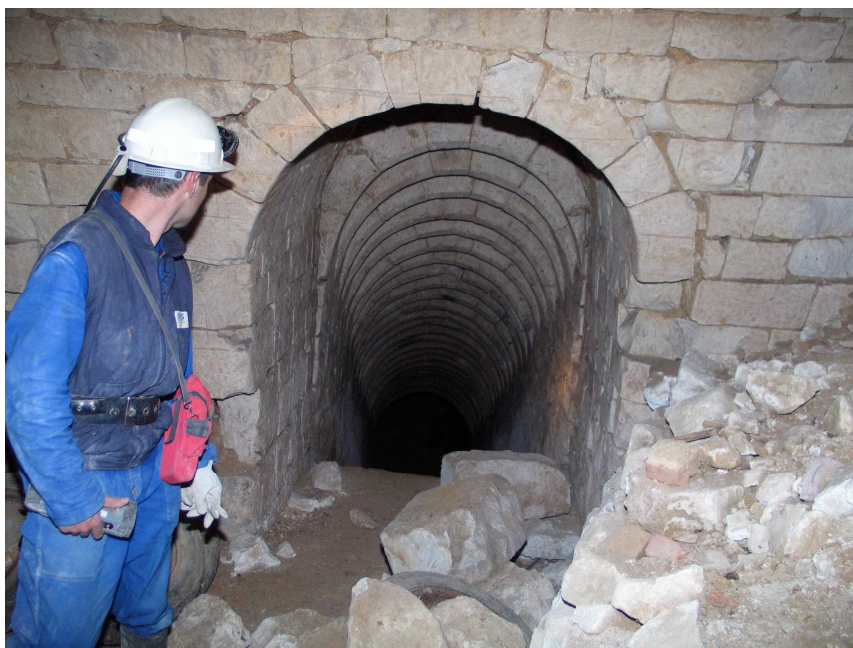
Photo 7 : souterrain de la Commanderie (escalier d'accès au niveau inférieur)
